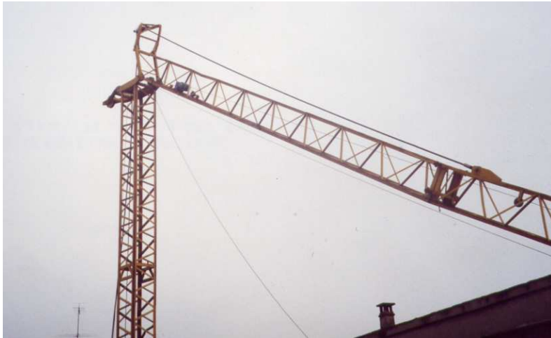
Figura 17 esempio di rottura del puntone di una gru a torre che ha provocato la caduta del braccio.
