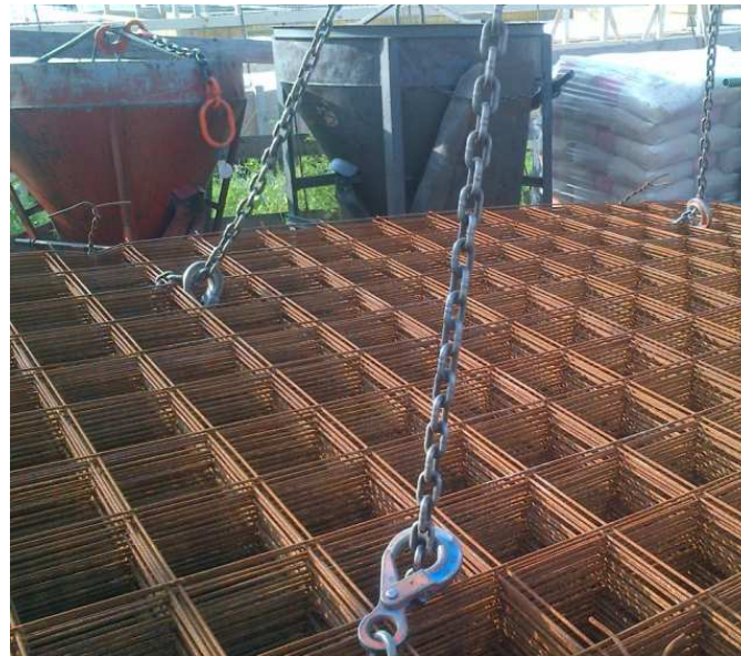
Figura 8 utilizzo di legacci di tondino metallico per le operazioni di sollevamento (sinistra). A destra uso corretto per mezzo di idonei accessori di sollevamento.
