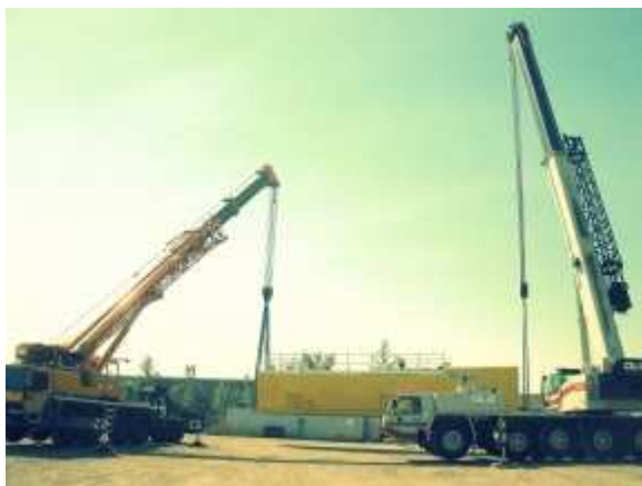
Figura 15 esempio di carico sollevato simultaneamente da due attrezzature di lavoro.
