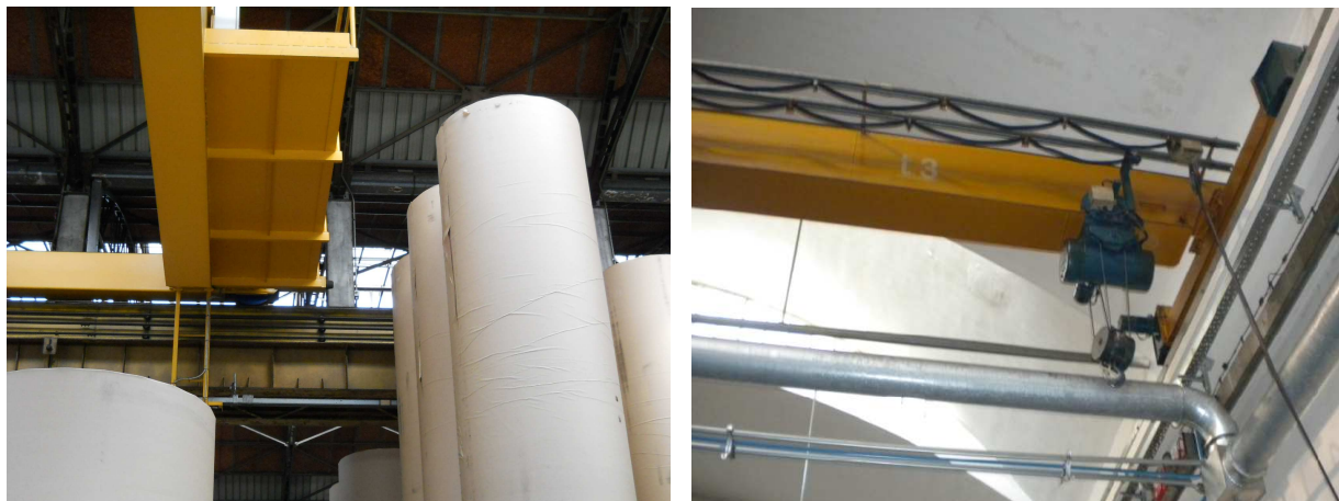
Figura 2 interferenza strutturale con ostacoli fissi (settore industria)
