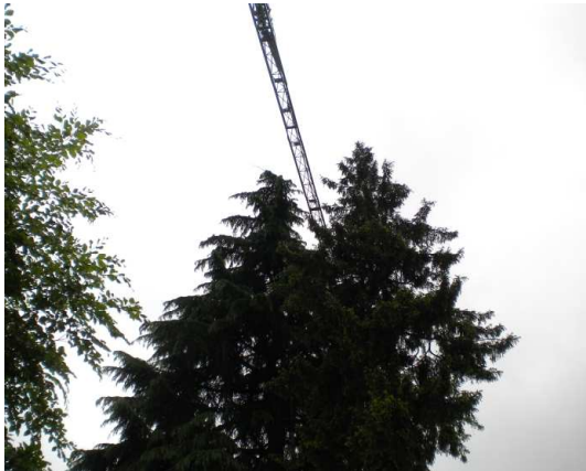
Figura 1 la rotazione del braccio è pregiudicata dalla presenza di un albero (settore costruzioni)
