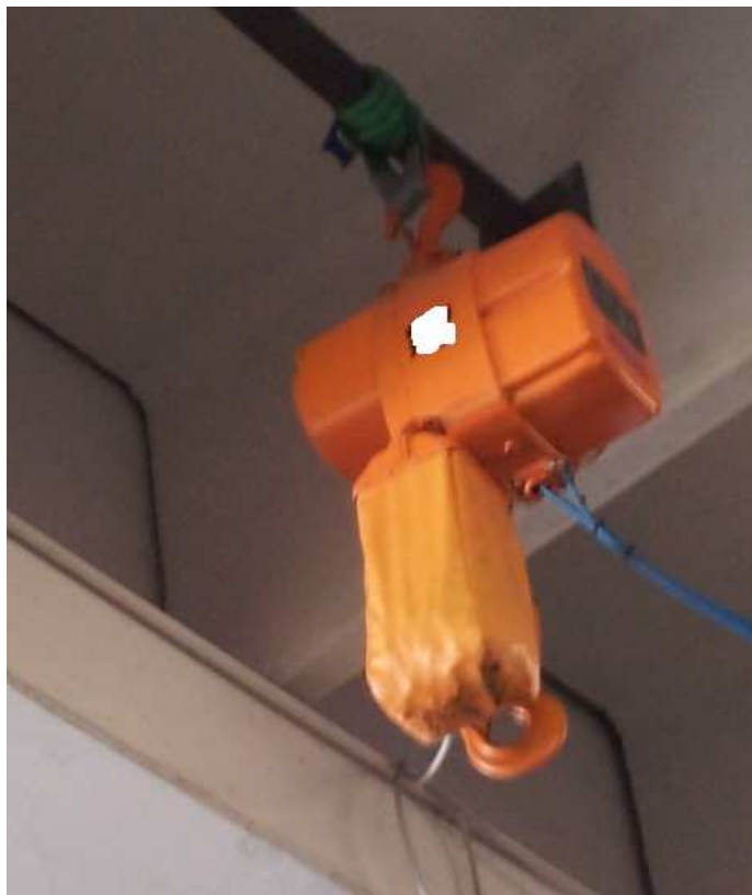
Figura 7 esempio di installazione eseguita non in conformità alle istruzioni fornite dal costruttore (paranco elettrico installato su tubolare in ferro. Il collegamento tra paranco e tubolare è garantito da una fascia tessile).
