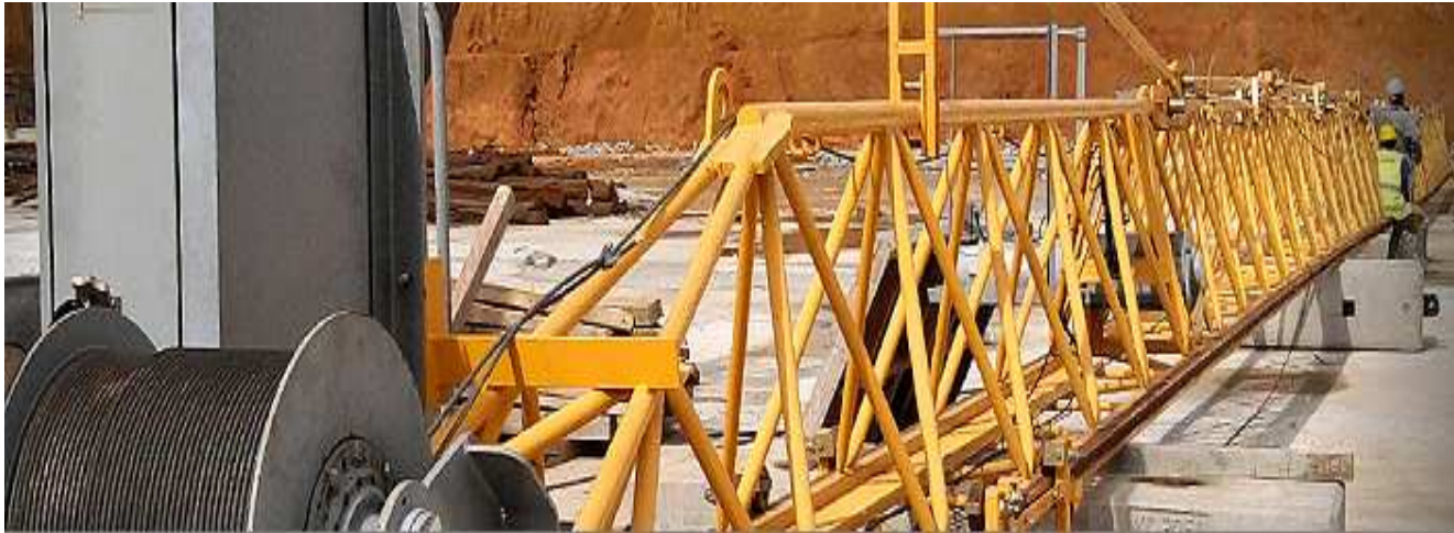
Figura 19 esempio di controllo iniziale in fase di montaggio di una gru a torre
