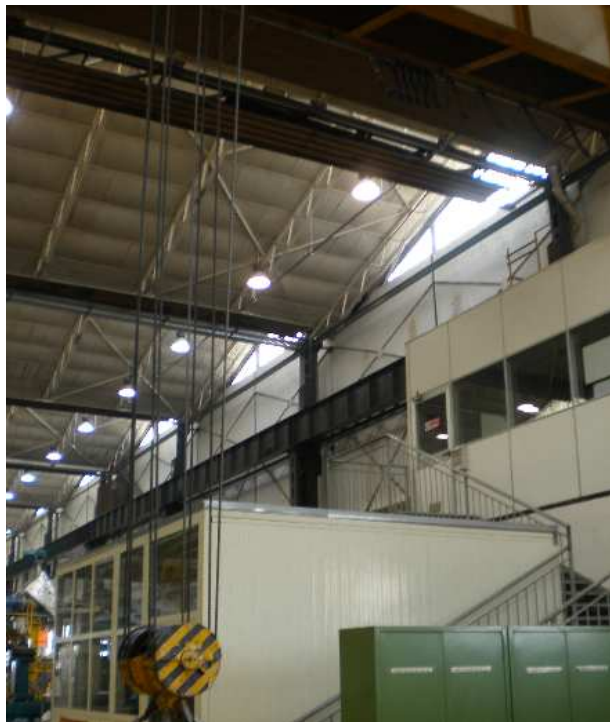
Figura 4 passaggio del carico sopra zone di lavoro occupare stabilmente da lavoratori
