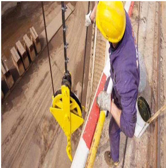
Figura 21 esempio di controllo trimestrale di funi e catene
