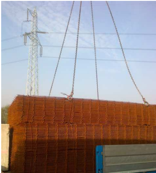
Figura 8 utilizzo di legacci di tondino metallico per le operazioni di sollevamento (sinistra). A destra uso corretto per mezzo di idonei accessori di sollevamento.
