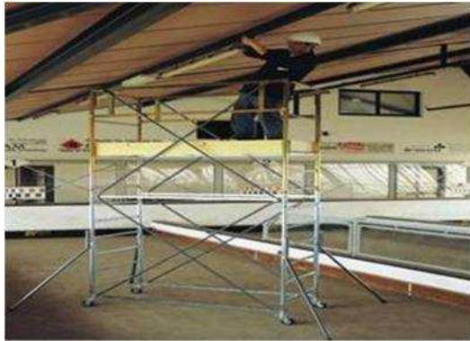
Figura 6 ponte di lavoro realizzato a tubi e giunti o a telai innestabili, dotati di ruotine di base
