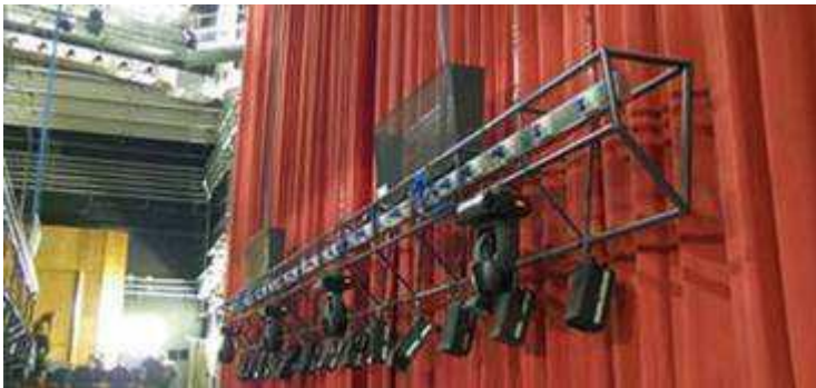
Figura 3 sistema di movimentazione e sospensione di allestimenti scenici
